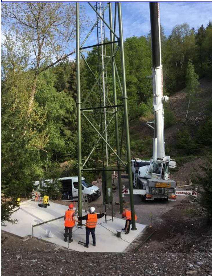
*Décrochage des attaches qui ont permis de mettre en place le pylône ↓*
